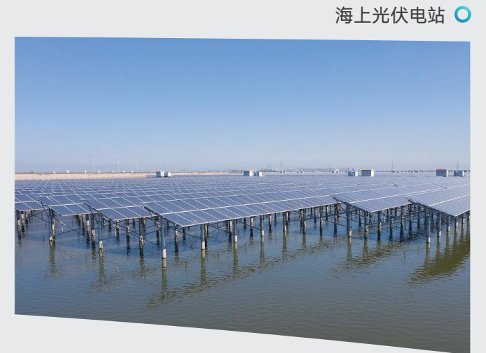
渔光互补光伏电站
