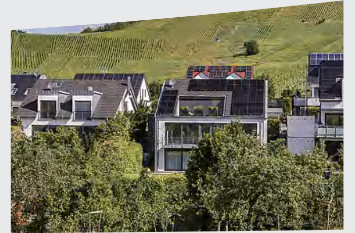
户用屋顶电站
